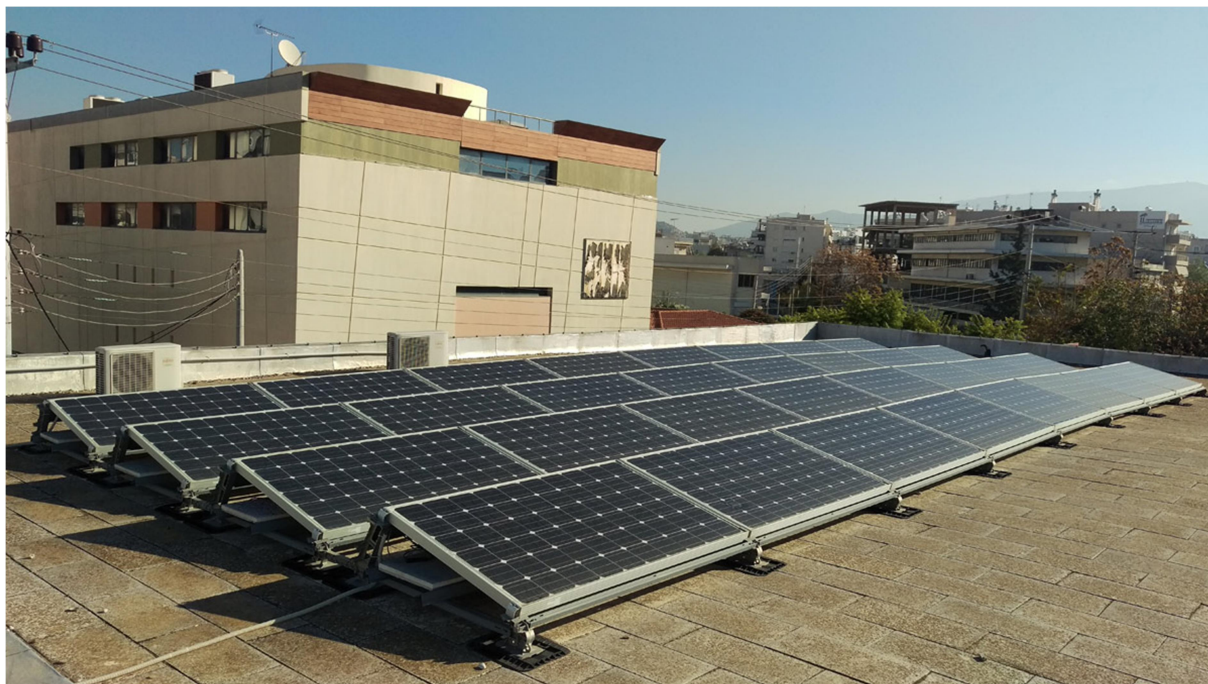
Εικόνα 4: Εγκατάσταση φωτοβολταϊκών πάνελ στο στο 4ο και 5ο Δημοτικό Σχολείο Μοσχάτου.
