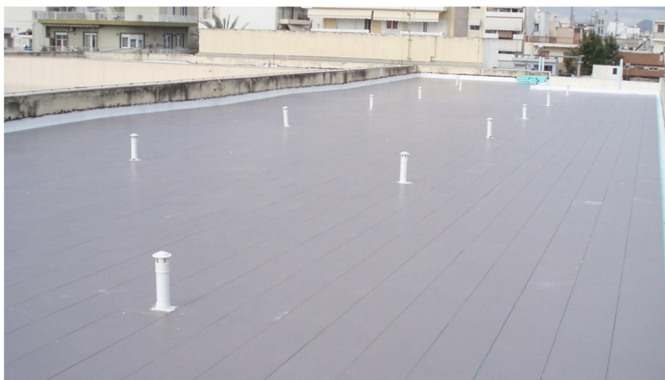
Εικόνα 20: Θερμοϋγραμόνωση δώματος.
