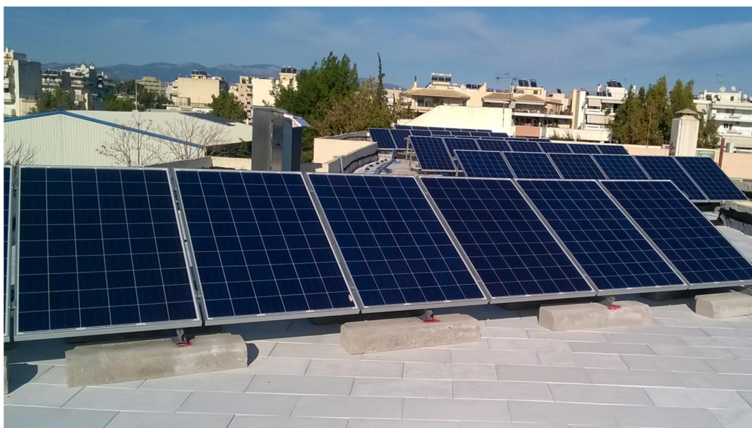
Εικόνα 3: Εγκατάσταση φωτοβολταϊκών πάνελ στο 2ο Λυκείου Μοσχάτου.
