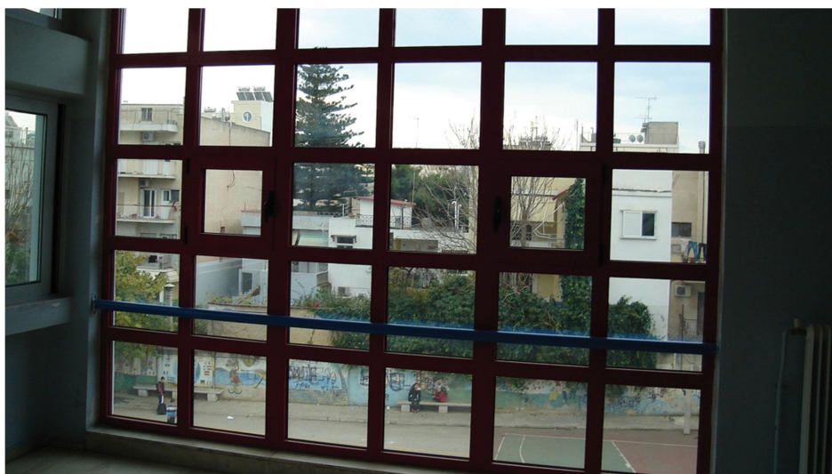
Εικόνα 23: Τα νέα πιστοποιημένα ενεργειακά κουφώματα του κτιρίου.
