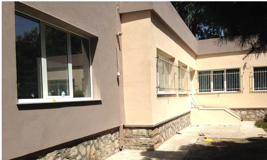
Εικόνα 29: Ο 1 ος Βρεφονηπιακός Σταθμός μετά τις παρεμβάσεις ενεργειακής αναβάθμισης.
