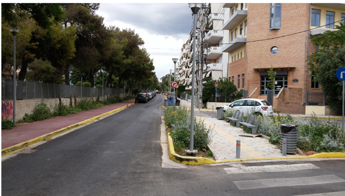
Εικόνα 41: Αναπλάσεις αστικού περιβάλλοντος στο πλαίσιο της μικροκλιματικής ανάπλασης του βορειοανατολικού τμήματος του Δήμου Μοσχάτου - Ταύρου.
