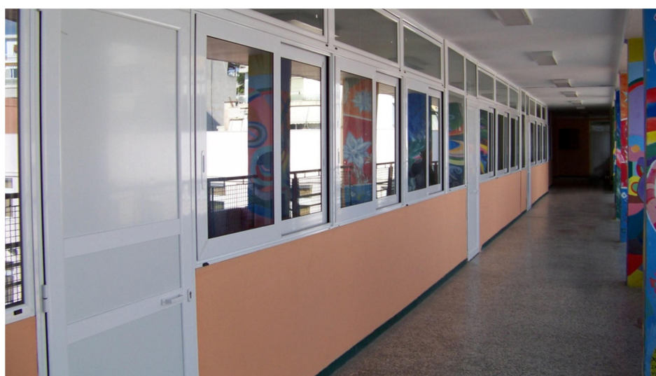
Εικόνα 7: Τα νέα πιστοποιημένα ενεργειακά κουφώματα του κτιριακού συγκροτήματος.
