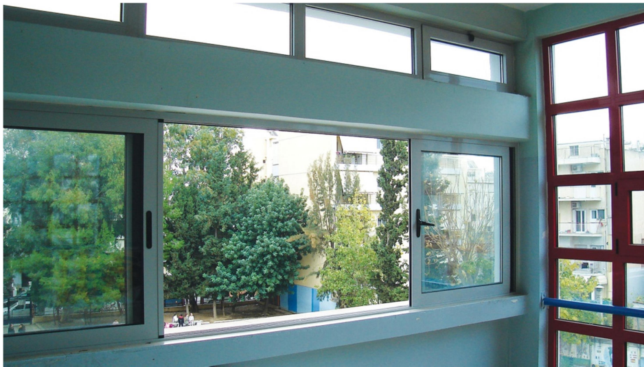
Εικόνα 27: Τα νέα πιστοποιημένα ενεργειακά κουφώματα του κτιρίου.
