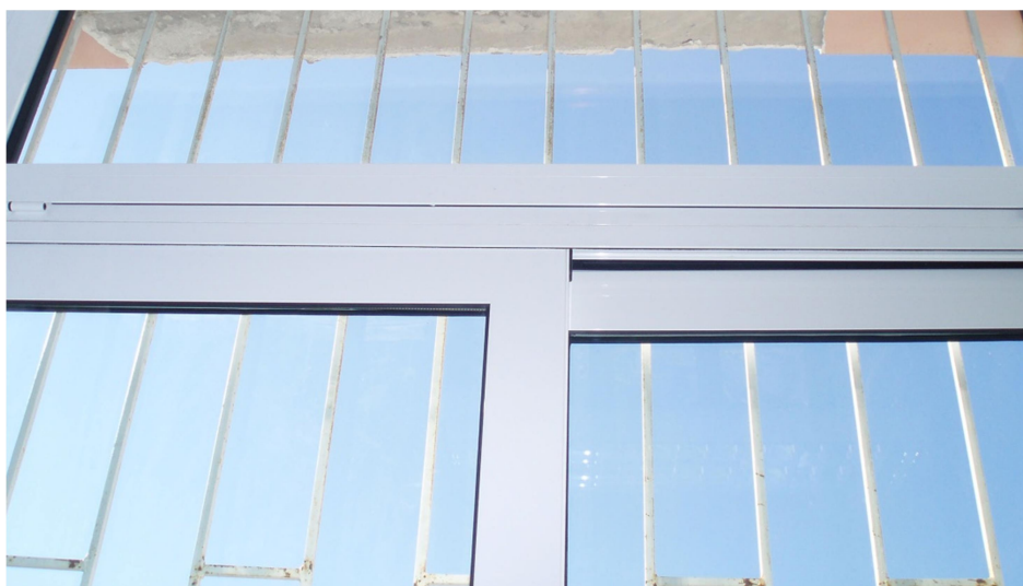
Εικόνα 21: Τα νέα πιστοποιημένα ενεργειακά κουφώματα του κτιρίου.
