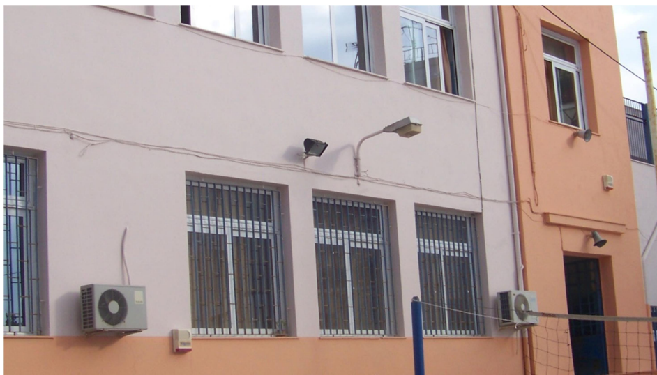
Εικόνα 9: Τα νέα πιστοποιημένα ενεργειακά κουφώματα του κτιριακού συγκροτήματος.
