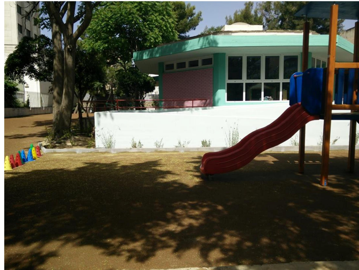
Εικόνα 36: Το 1 ο Νηπιαγωγείο Μοσχάτου μετά τις εργασίες αλλαγής κουφωμάτων.
