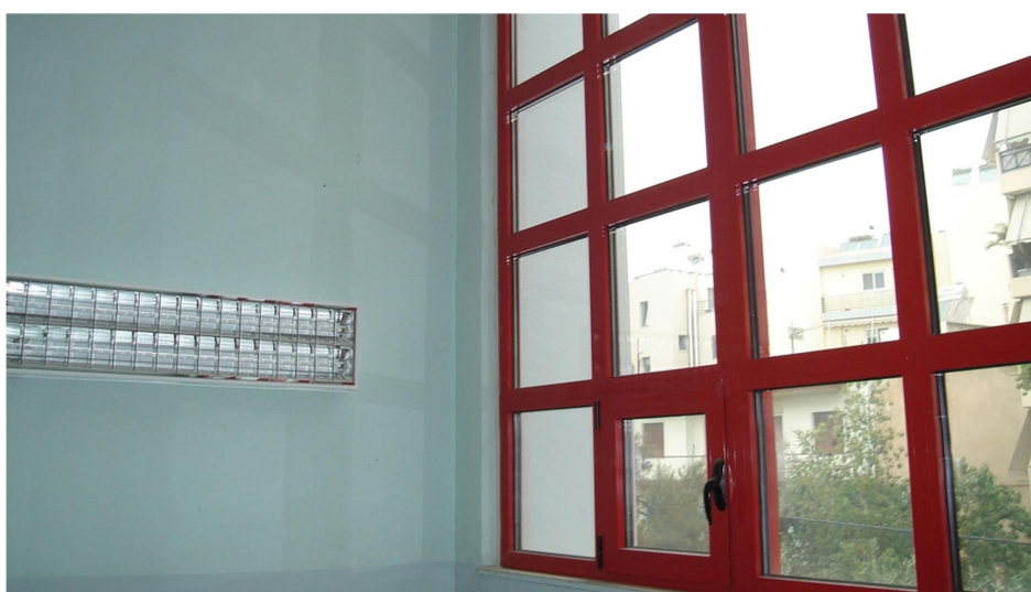
Εικόνα 25: Τα νέα πιστοποιημένα ενεργειακά κουφώματα του κτιρίου.
