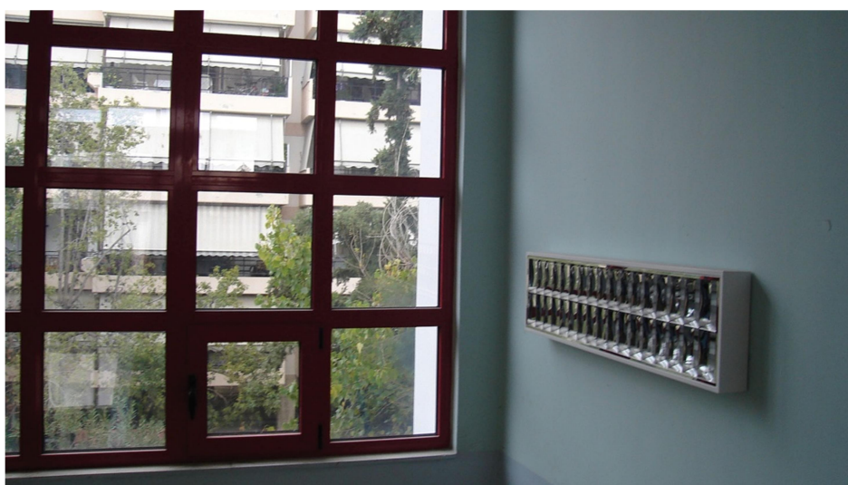
Εικόνα 24: Τα νέα πιστοποιημένα ενεργειακά κουφώματα του κτιρίου.
