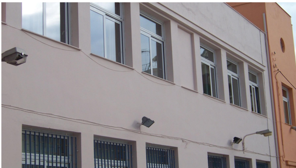
Εικόνα 10: Τα νέα πιστοποιημένα ενεργειακά κουφώματα του κτιριακού συγκροτήματος.
