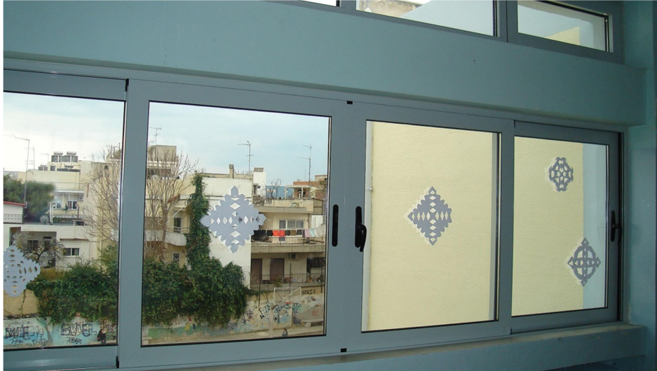
Εικόνα 26: Τα νέα πιστοποιημένα ενεργειακά κουφώματα του κτιρίου.
