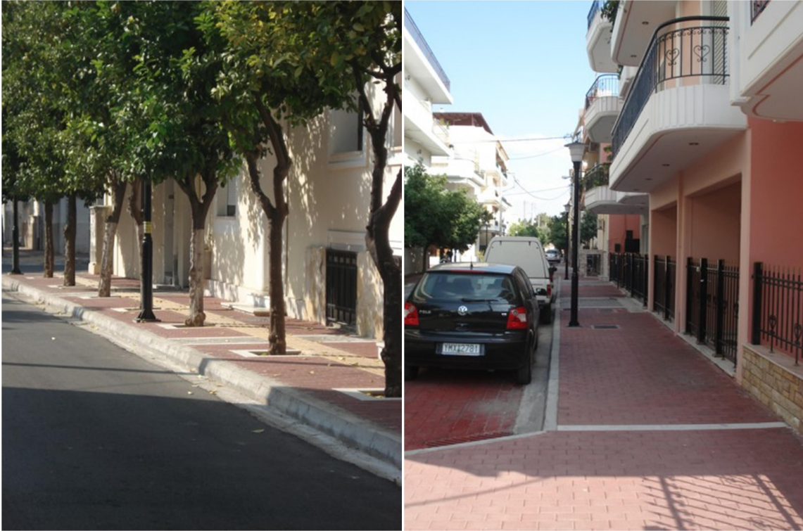
Εικόνα 42: Κατασκευή και βελτίωση οδών περιοχής Εσταυρωμένου.
