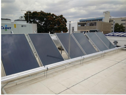
Εικόνα 33: Εγκατάσταση ηλιακών συλλεκτών στο δώμα και όψη του αύλειου χώρου.
