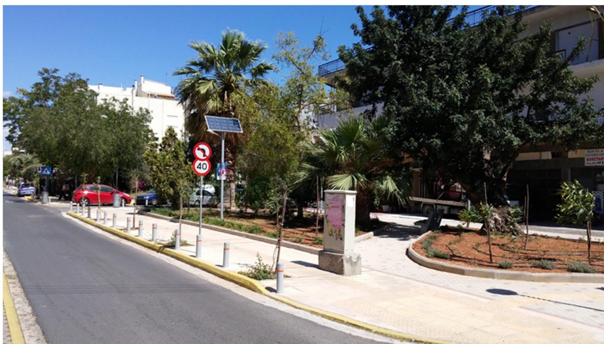
Εικόνα 39: Αναπλάσεις αστικού περιβάλλοντος στο πλαίσιο της μικροκλιματικής ανάπλασης του βορειοανατολικού τμήματος του Δήμου Μοσχάτου - Ταύρου.
