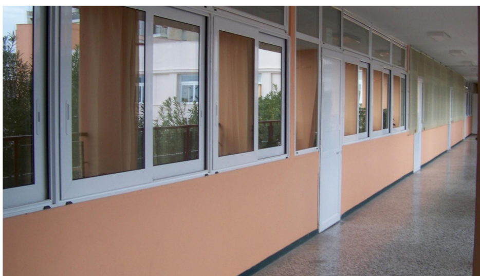
Εικόνα 6: Τα νέα πιστοποιημένα ενεργειακά κουφώματα του κτιριακού συγκροτήματος.
