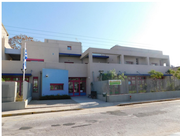
Εικόνα 31: Ο 1 ος Βρεφονηπιακός Σταθμός μετά τις παρεμβάσεις ενεργειακής αναβάθμισης.
